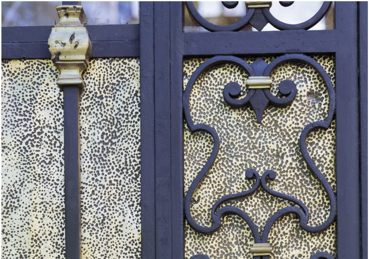
po renowacji, 2017 r.
