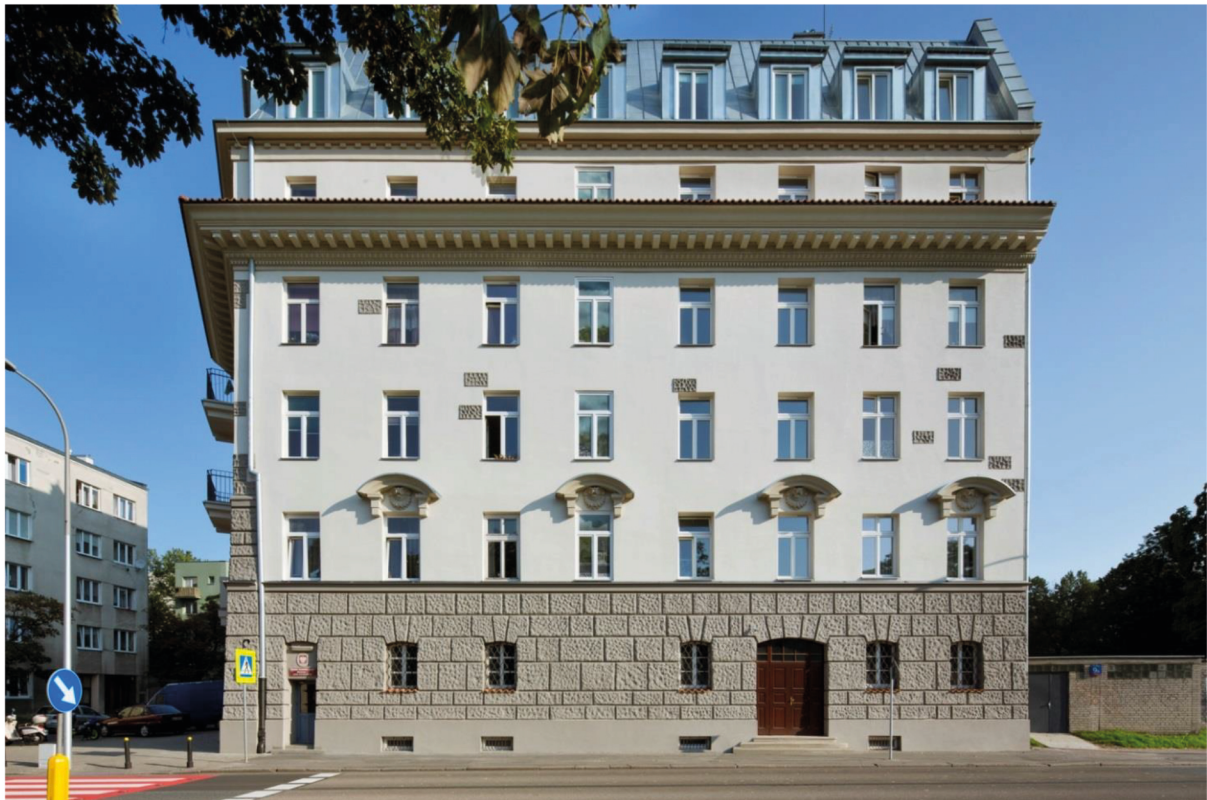
po rewitalizacji, 2017 r.
